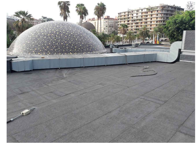
Detalle 1 Cubierta donde se ubica el Campo Fotovoltaico
