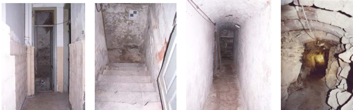
11. Secuencia del acceso a la Cámara de Reflexión.
