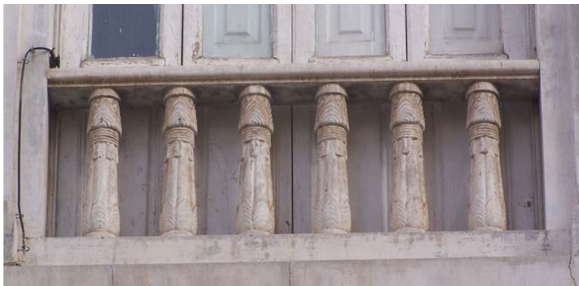
8. Antepecho de las ventanas de fachada formado por pequeñas columnas.
