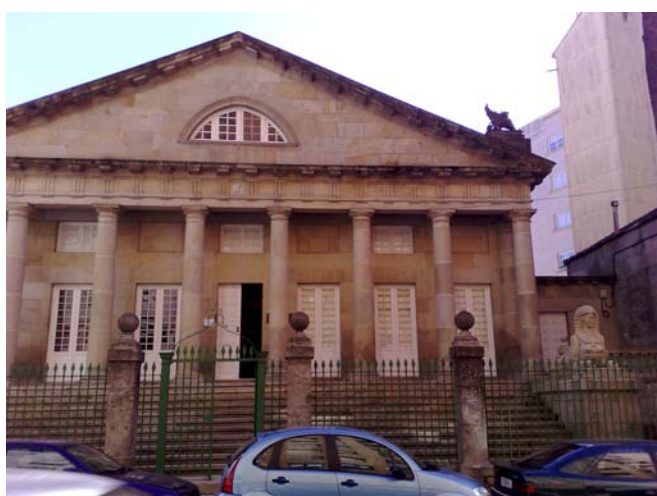
4. Fachada de la Casa Fonseca, actual sede del Archivo Provincial de Pontevedra.
