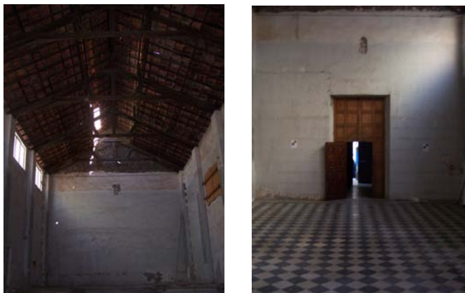
17. Vistas interior de la cubierta y pavimento del Salón de Tenidas en la actualidad.
