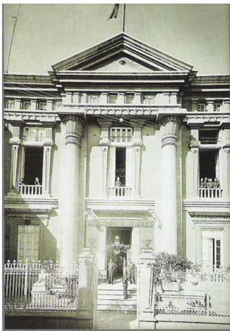
4. Fachada en la década de los años 40, ya ocupado el edificio por la Falange Española.
